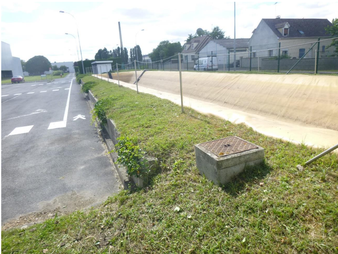
Figure 4-8 : Parking et réseaux dans l'emprise du bassin de compensation à supprimer
