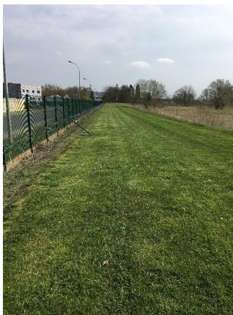
Figure 2-2 : Digue de l'ARC longeant le nord du site
